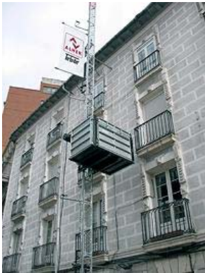
Montacargas vertical de fachada
