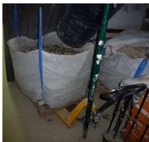
Transpaleta manual (situada a la salida de una tolva).
