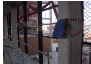
Estructura auxiliar Fachada panel
