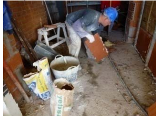
Acopio de material en el tajo
