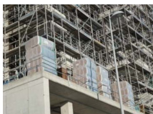
Acopio de lana de roca
