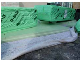
Geotextil y paneles rígidos XPS
