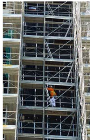
Andamio prefabricado de fachada
