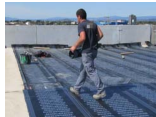
Transporte de tela asfáltica
