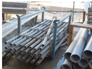
Contenedores de material (grúas)
