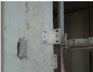
Anclajes para estructura soporte fachada ventilada
