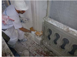
Molduras de escayola in situ
