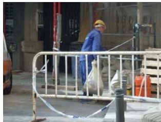
Manipulación de escombros en sacos.
