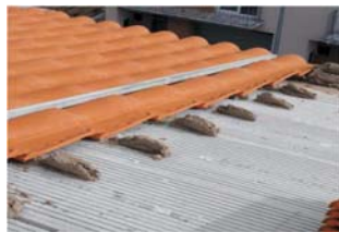
Paneles aislantes bajo teja
