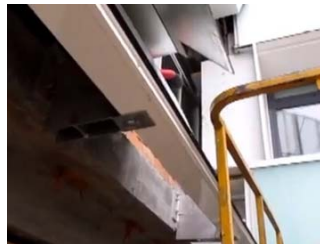
Montaje perfil inferior
