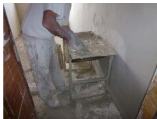
Utilización de pasteras elevadas
