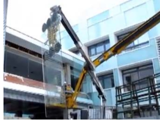
Izado a zona de colocación
