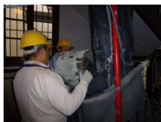
Vertido de escombros en trompa de vertido
