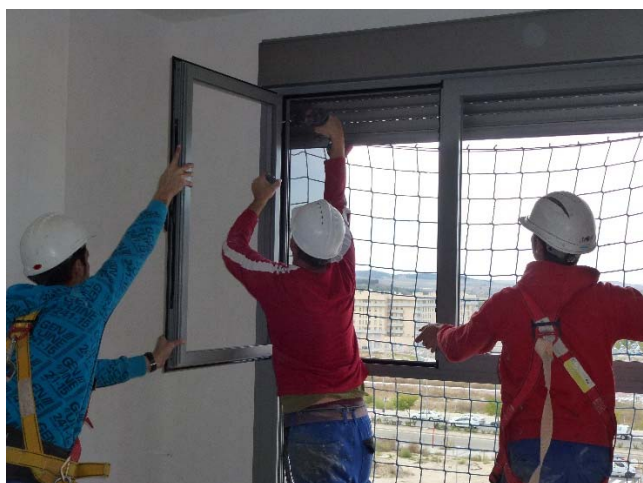
Montaje y fijación de carpintería exterior
