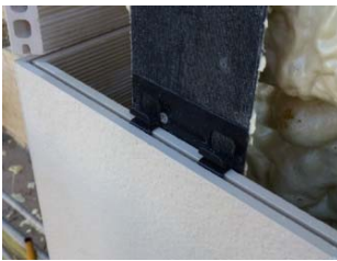
Detalle del anclaje de la pieza
