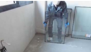
Posicionado manual de vidrio
