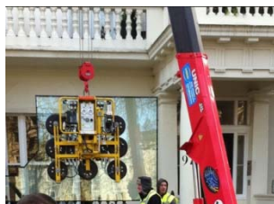
Elevación de vidrio con ventosas de vacío (9 ventosas)
