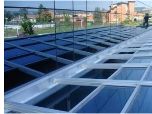
Fachada (muro cortina) y cubierta acristalada
