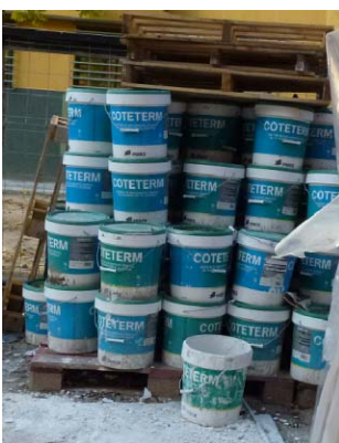
Revestimiento acrílico (acopio)
