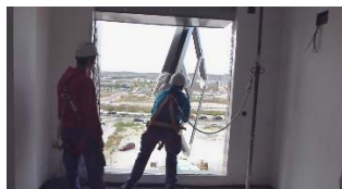
Recepción de carpintería en hueco
