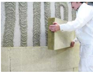
Montaje paneles SATE
