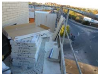
Acopio de baldosas en monomástil
