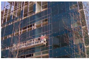
Muro corina acristalado
