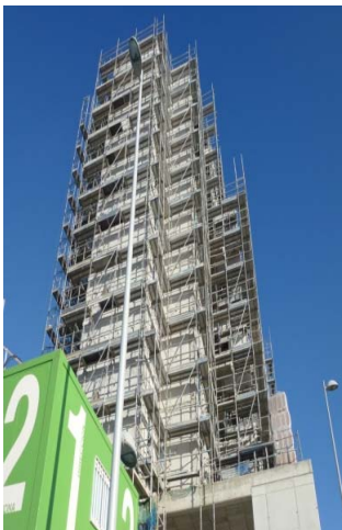
Andamio prefabricado de fachada
