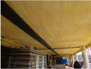
Poliuretano Proyectado por exterior de suelo
