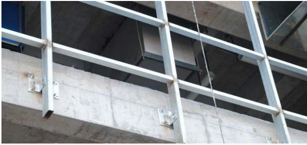
Estructura soporte para muro cortina
