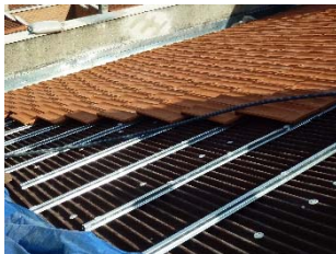
Chapa ondulada, rastreles y cubrición
