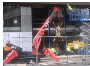
Montaje de vidrio con ventosas de vacío (4 ventosas)
