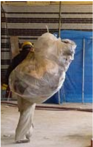
Manipulación de escombros en sacos (restos de embalajes)
