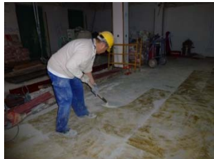
Retirada de suelo existente
