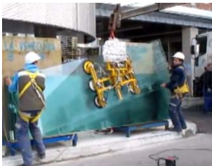
Inicio de izado de vidrio
