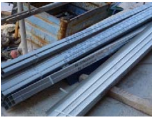
Acopio de perfilería para placas de yeso laminado.
