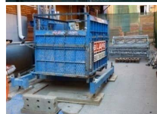
Montacargas de 500kg. Anclaje al andamio tubular.
