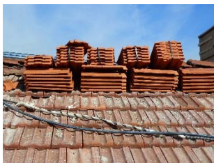
Cubrición con teja (acopio)
