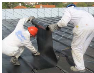
Extendido de tela asfáltica
