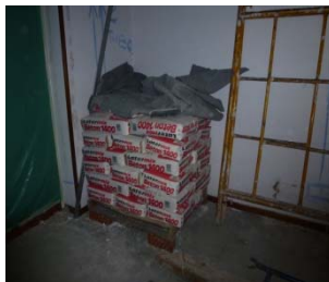
Carga paletizada para transporte con transpaleta
