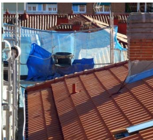
Boca de trompa de vertido en cubierta
