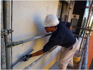
Aplicación mortero de fijación
