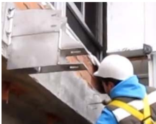
Montaje de estructura soporte
