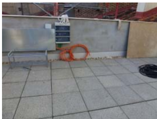
Cubierta con losa filtrante
