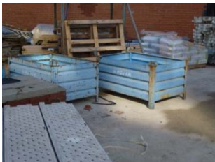
Contenedores de material (grúas)
