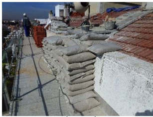
Sacos de arena (acopio)
