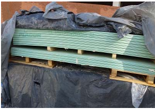
Placas de yeso laminado (acopio)
