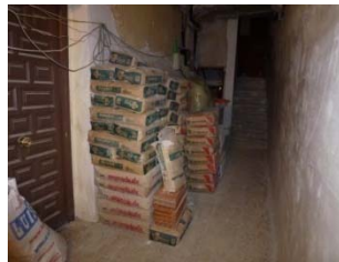
Acopio de sacos dejando amplitud de paso
