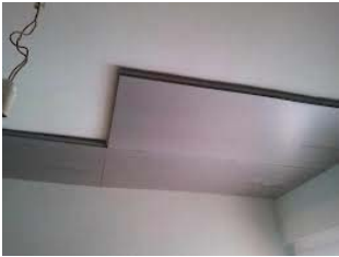
Paneles de poliestireno extruido por exterior de suelo
